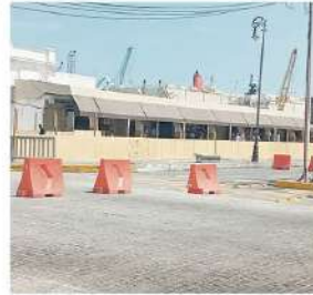
EL PASEO DEL MALECÓN luce amurallado con tablas por los trabajos que se realizan del colector pluvial.
