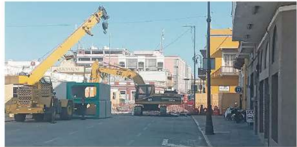
MAQUINARIA pesada se observa en las inmediaciones del Centro Histórico de Veracruz.
