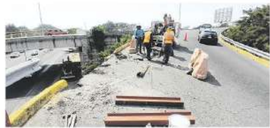
PERSONAL del ayuntamiento porteño colocó los pilotes metálicos faltantes.
