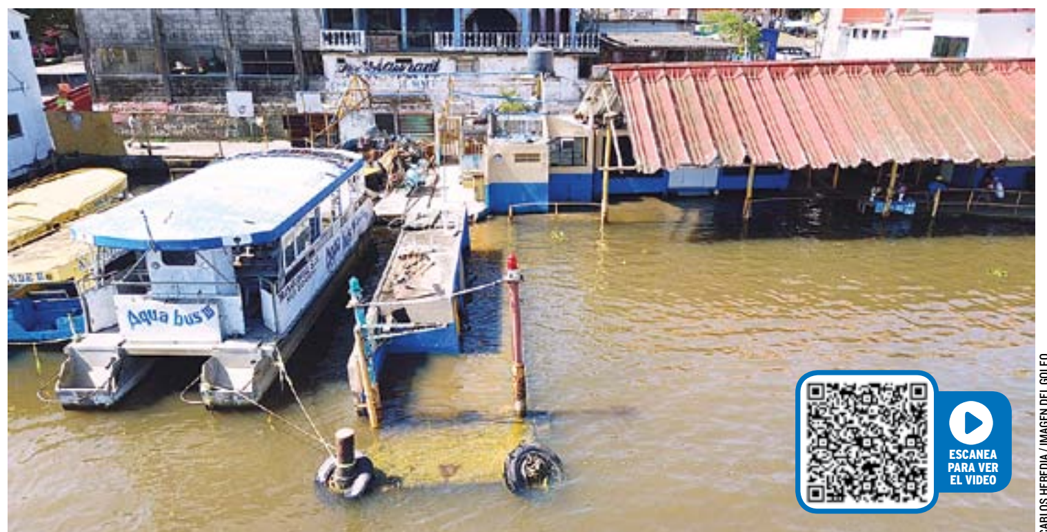
ESTA PARTE DEL MUELLE en el paso de lanchas, es la que se fue de lado luego de los torrenciales aguaceros que se habría llevado la arena de la parte inferior.
