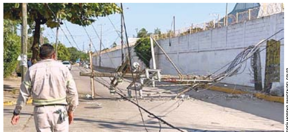
EL POSTE DE CONCRETO que se encontraba ya en pésimas condiciones, se precipitó al suelo.
