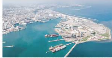
EL PROYECTO de la nueva en Bahía Norte se encuentra concluida en su infraestructura.
