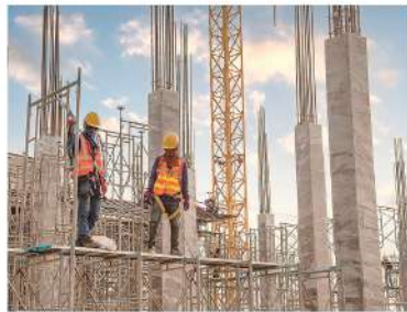
LOS INCREMENTOS del acero y el aluminio dificultan la planeación financiera de las obras, expuso el Colegio de Ingenieros Civiles de Veracruz.
