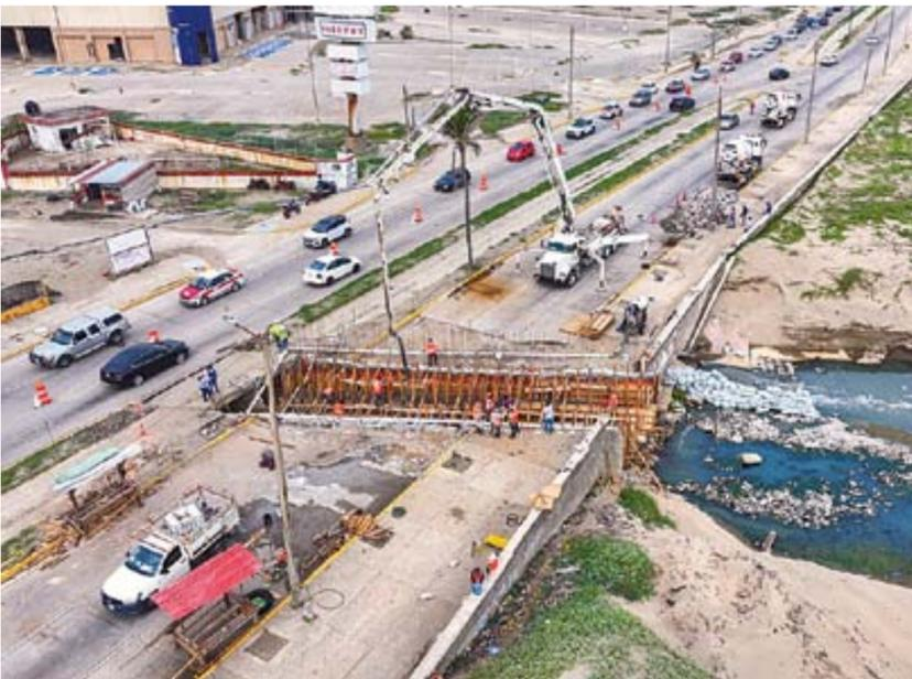
**30% de avance.** La obra de rehabilitación del drenaje pluvial, mediante la construcción de un canal sobre el malecón costero, registra un avance del 30%. Ayer se realizó el suministro y vaciado de 49 metros cúbicos de concreto premezclado, especialmente formulado para resistir sulfatos y ambientes marinos.
